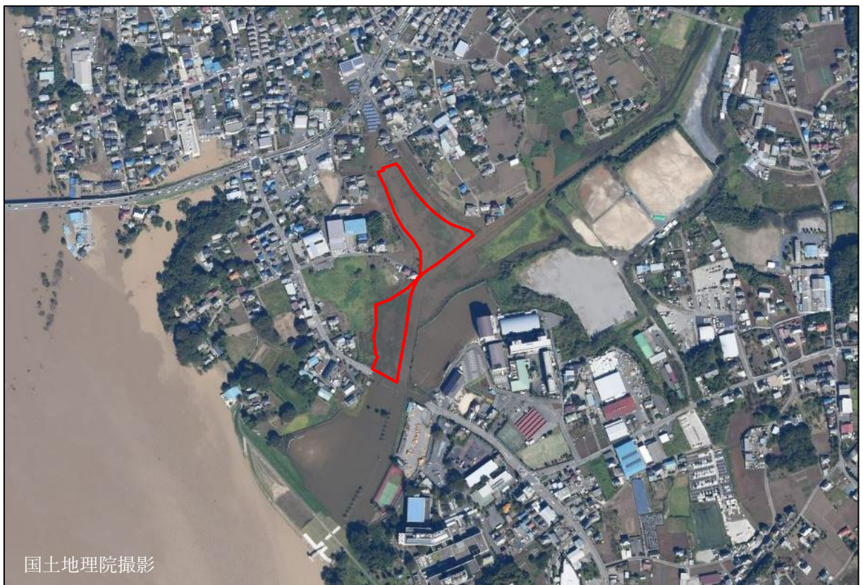
令和元年台風19号浸水被害状況写真
