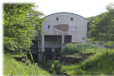
丸山ポンプ場
