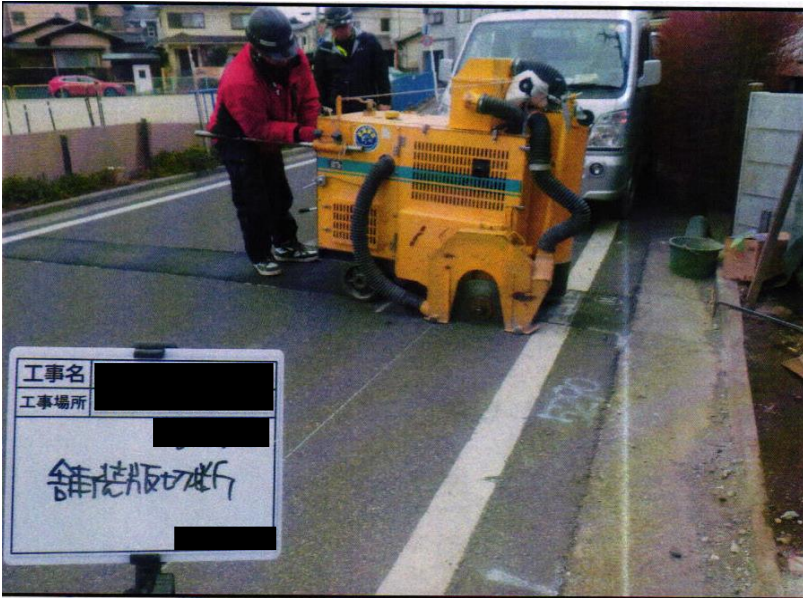
③④舗装版切断工 乾式
