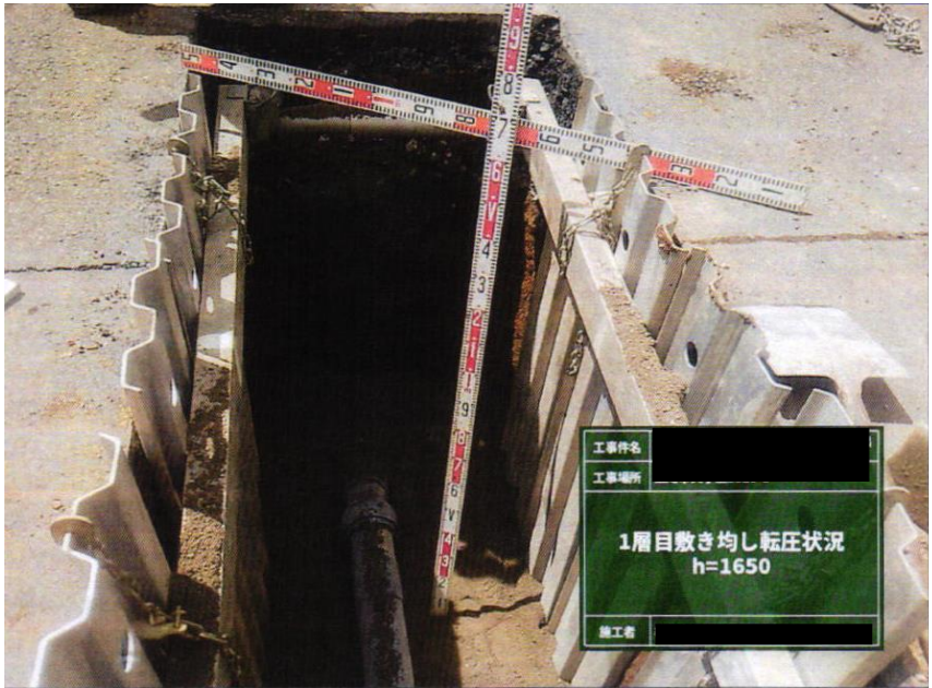
③⑧ 管路埋戻 砂 検尺
