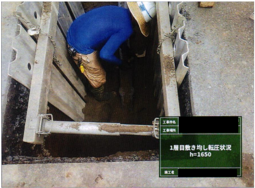
③⑥ 管路埋戻 砂 敷き均し
