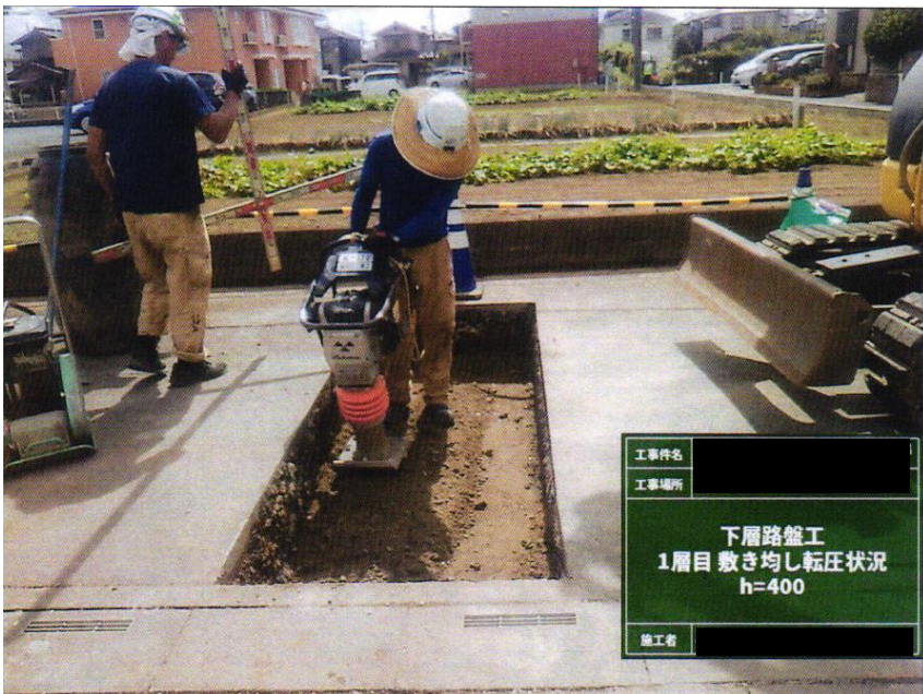
④⑩路盤工埋戻 切込砕石 転圧
