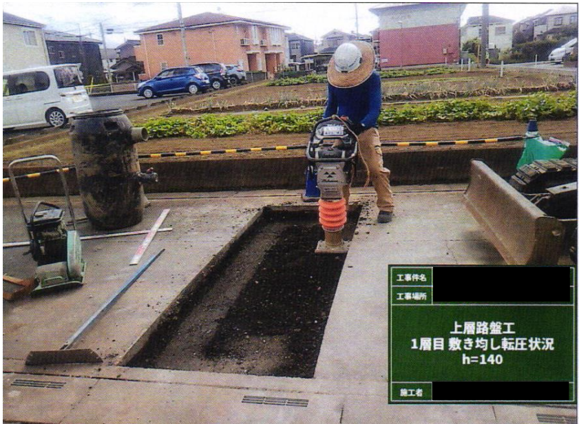
④③路盤工埋戻 粒度調整碎石 転圧
