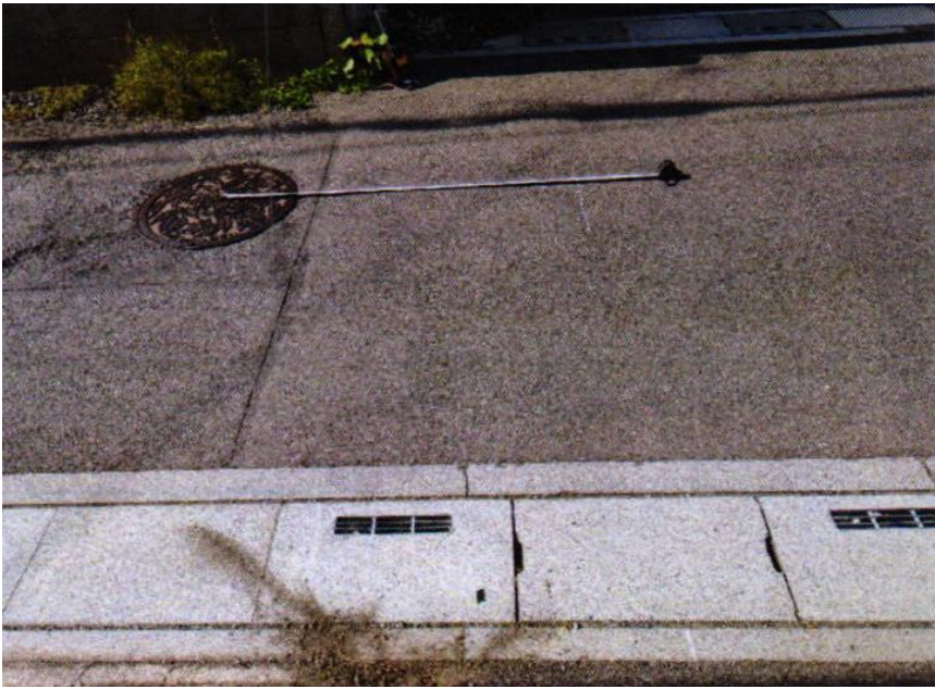
③③上流人孔からの距離 全景
