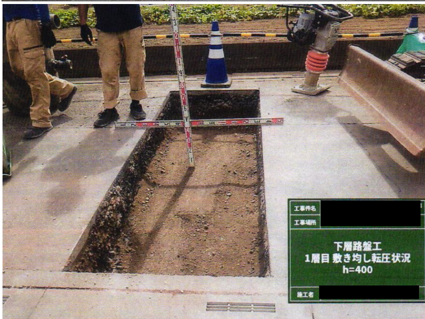
④⑪路盤工埋戻 切込砕石 検尺
