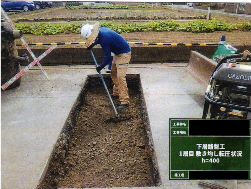
③⑨路盤工埋戻 切込砕石 敷き均し
