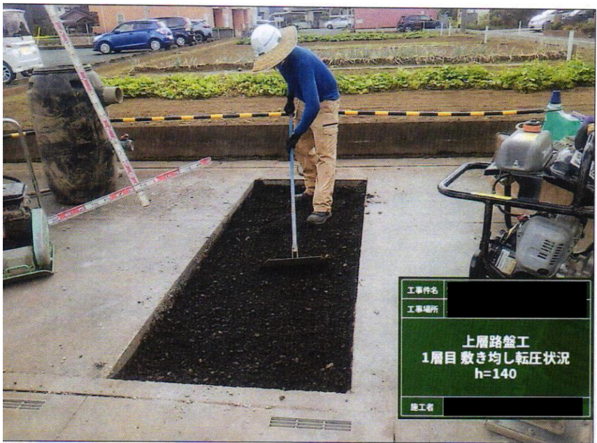
④②路盤工埋戻 粒度調整碎石 敷き均し
