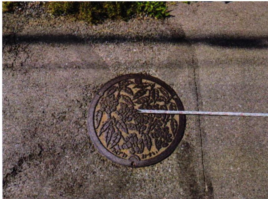
③④人孔部分撮影
