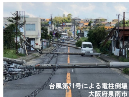
台風により倒壊した電柱
