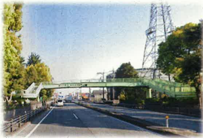
現在の運動公園歩道橋
