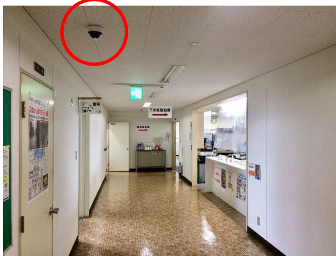
防犯カメラの設置（下水道施設課）
