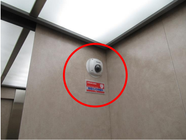
防犯カメラの設置（エレベーター内）
