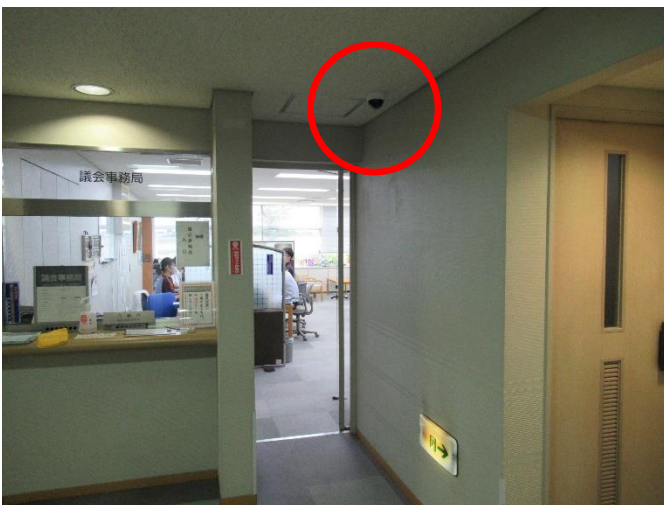
防犯カメラの設置（議会棟）
