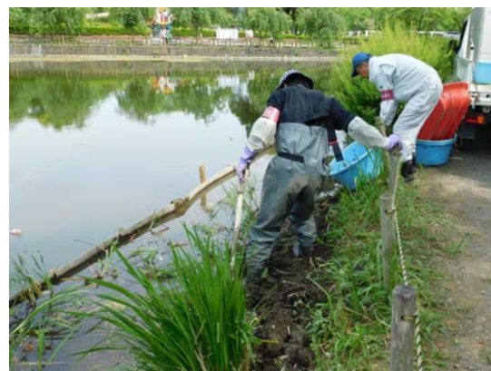
深すぎた箇所に湿地の泥を補充し、水位を調整 (2023年5月)
