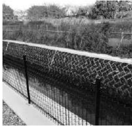
護岸工事が進む上尾中堀川
