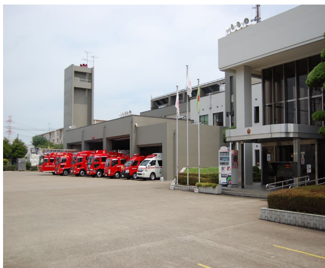
【 上尾市消防本部・上尾市東消防署 外観 】
