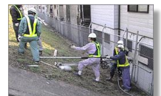
地下水排除工の例
