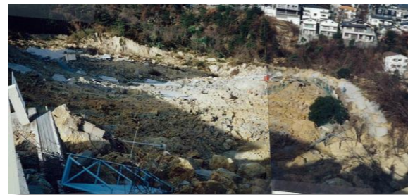
阪神・淡路大震災による盛土崩落
