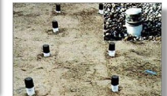
過剰間隙水圧消散工の例
