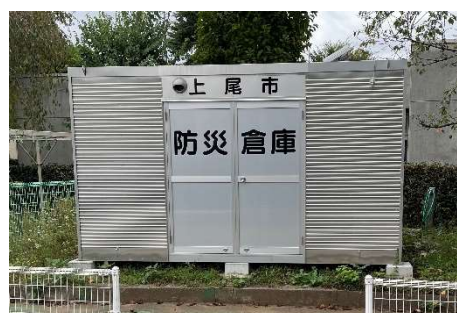
学校敷地内の防災倉庫
