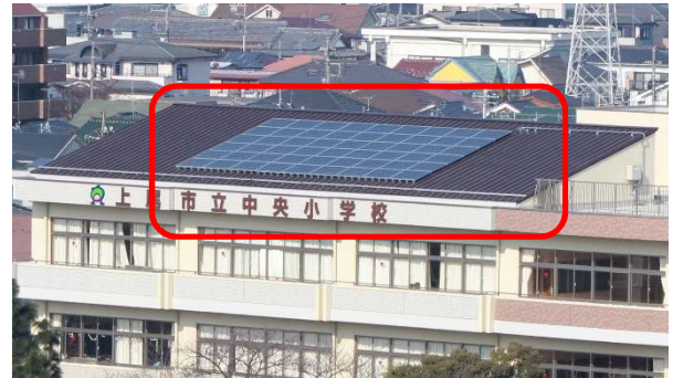
中央小学校の太陽光パネル
