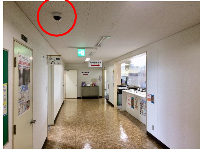
防犯カメラの設置（下水道施設課）
