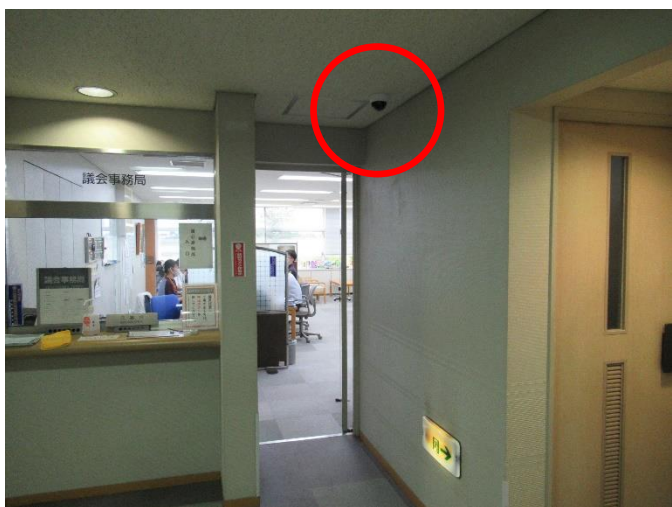
防犯カメラの設置（議会棟）
