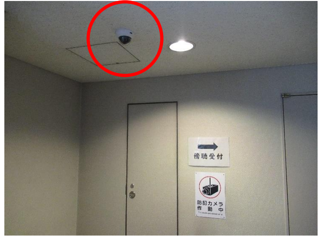
防犯カメラの設置（議会棟）
