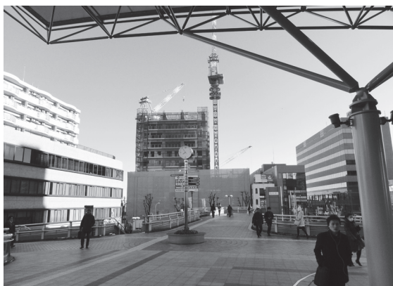
延伸される予定の東口ペDESTリアンデッキ
