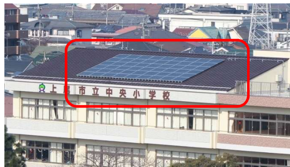
中央小学校の太陽光パネル
