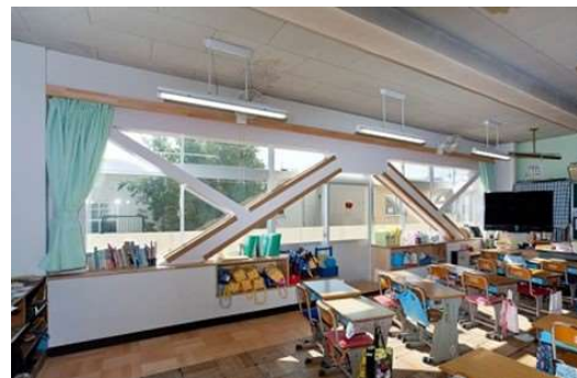
耐震補強後の教室の様子
