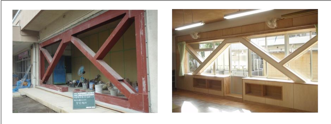
図表 3-10 耐震性向上の施工（公共建築物の例）
