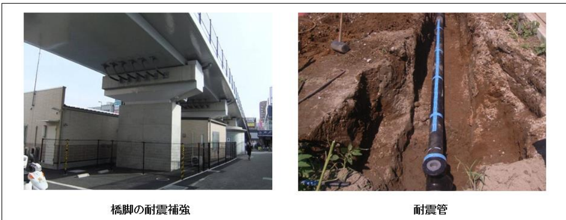
図表 3-11 耐震性向上の施工（都市基盤施設の例）
