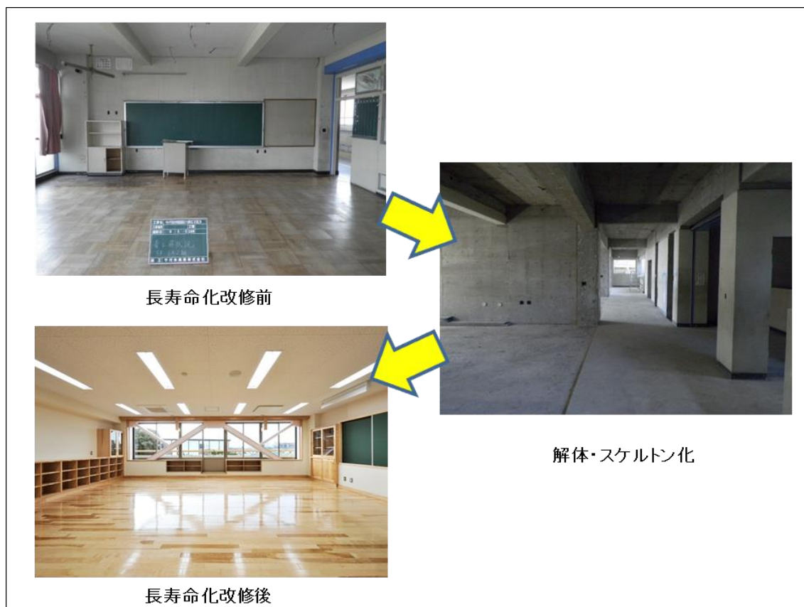
図表 3-12 長寿命化工事の例
