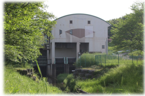
丸山ポンプ場
