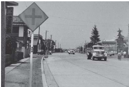
昭和37年5月 国道17号が開通
