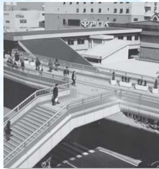
平成7年2月 JR上尾駅西口歩行者横断施設が開通
