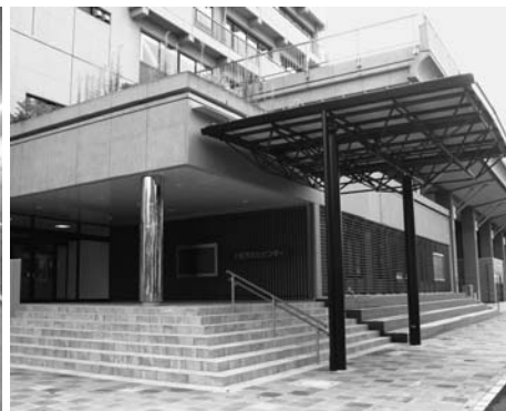
③正面玄関付近
