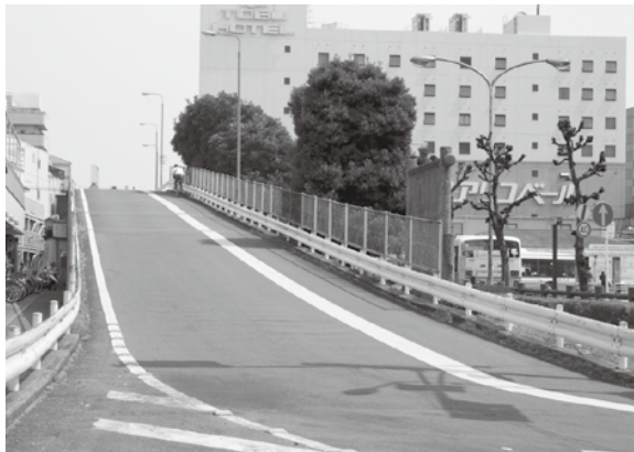
耐震補強工事が行われる宏栄橋
