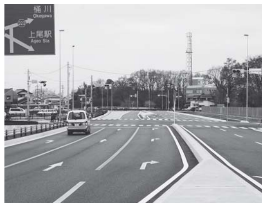
供用開始された上尾道路(壱丁目北信号付近)
