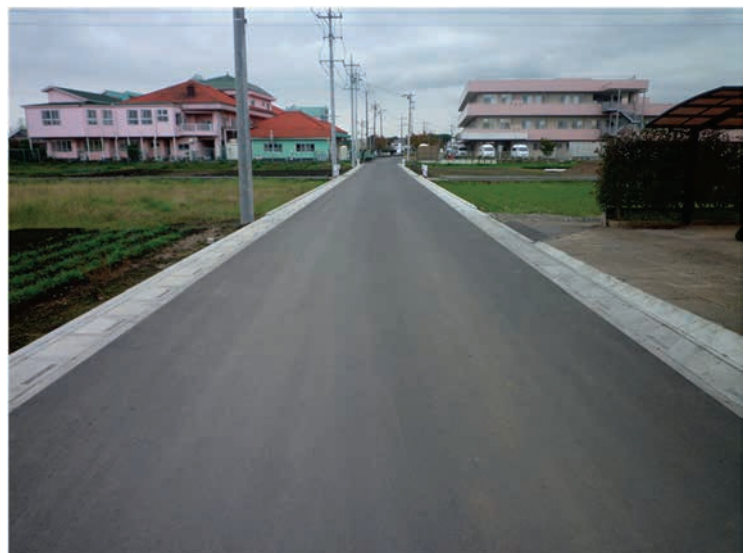
拡幅された道路
