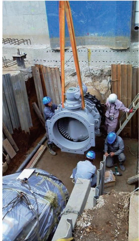
水道管路交換工事の様子
