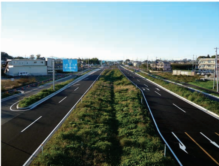
整備が進む上尾道路
