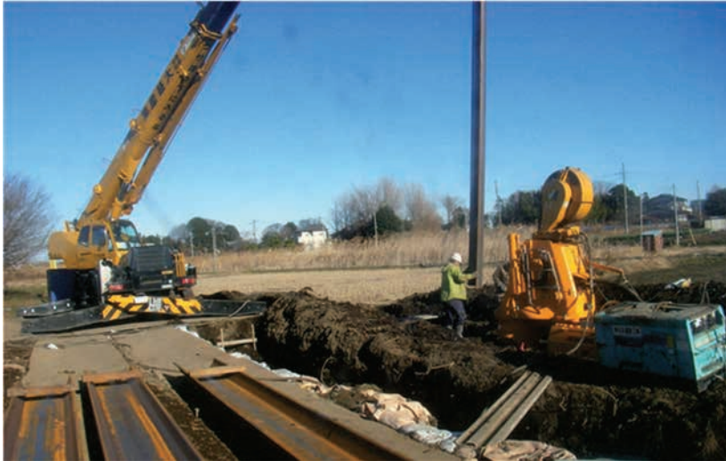
都市下水道工事の様子
