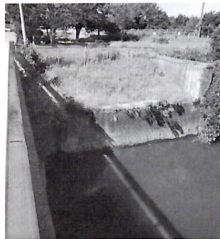
写真2 掛樋北翼壁(右上)と橋台翼壁(下)
