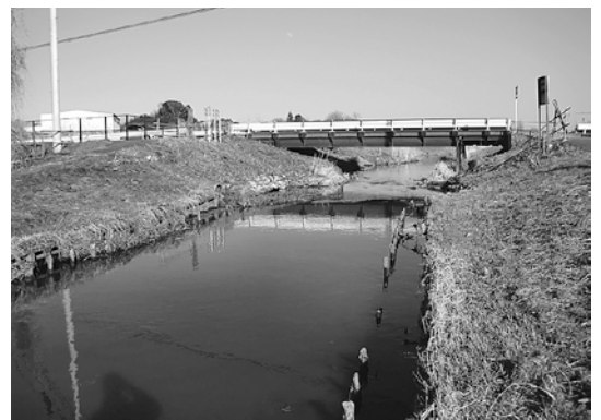
現在の境橋仮橋
