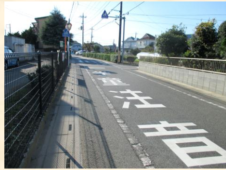
ブロック塀の一部を透視可能にすると共に、 注意喚起の路面表示を行いました
