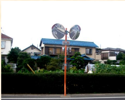
道路上に建柱されたカーブミラー
