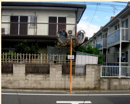
道路上に建柱されたカーブミラー
