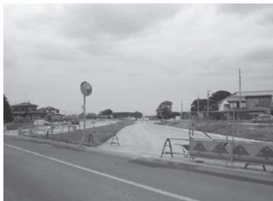
工事が進む上尾道路予定地（大字畔吉地内）
