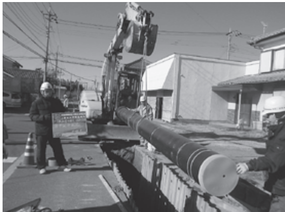
上水道工事の様子
