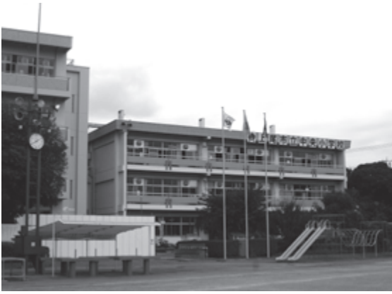
改築工事する中央小学校南校舎東棟
