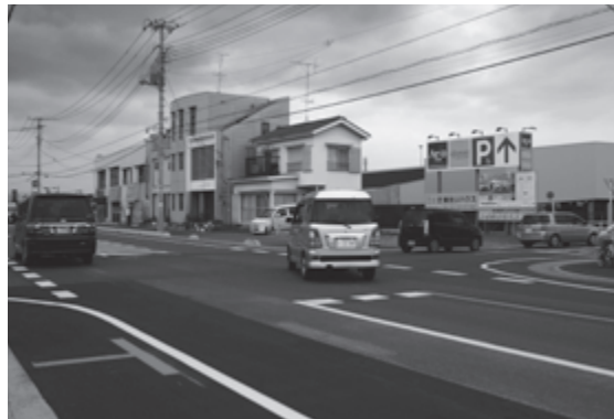
現在は右折帯などが設置された交差点 (7月3日撮影、大型ショッピングセンター周辺)
