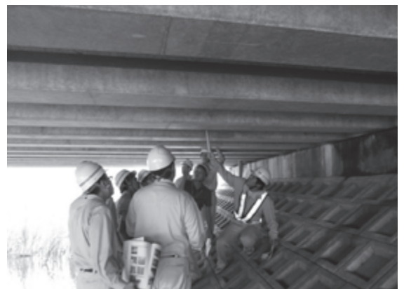
市内の橋の点検・調査 (写真は新弁財橋)
