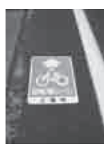
車道に設置された自転車レーン
