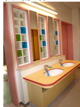
〔トイレ改修工事〕
