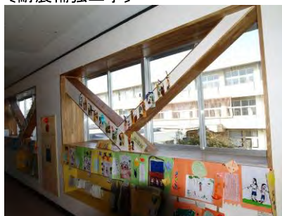
〔耐震補強工事〕
