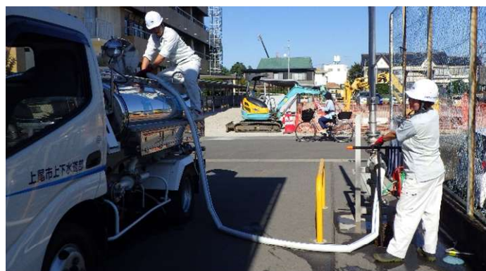
2.給水車への注水
