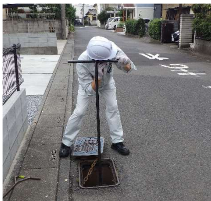
仕切弁からの音を確認して 水量を調整
