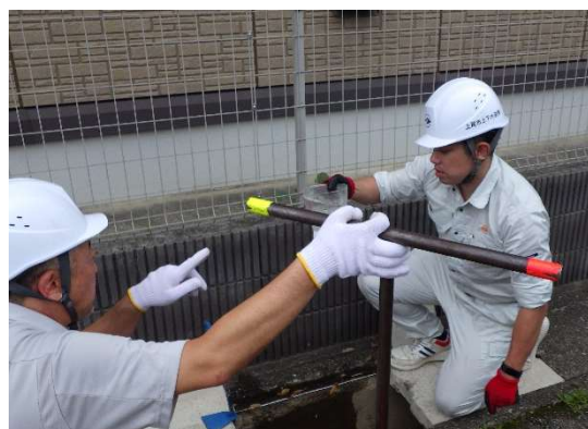
洗浄中の水質を目視にて確認
