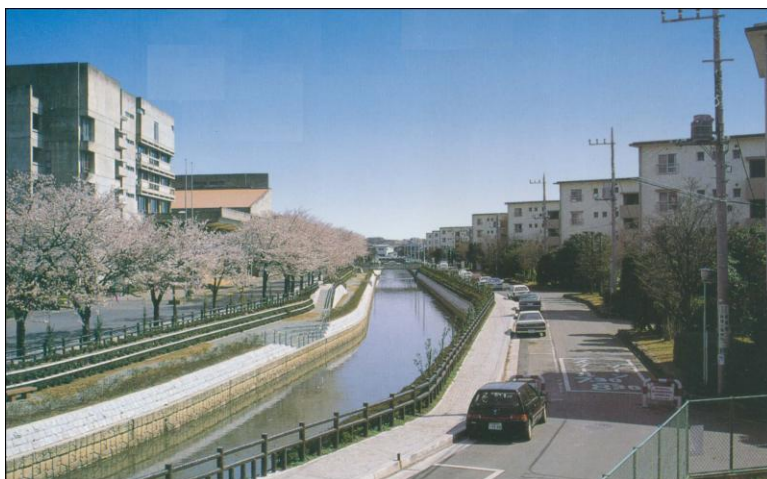
芝川都市下水路（上尾市文化センター前 下水道水緑景観モデル事業）
