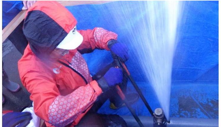
バール等を用いてサドル分水栓を漏水箇所に移動
