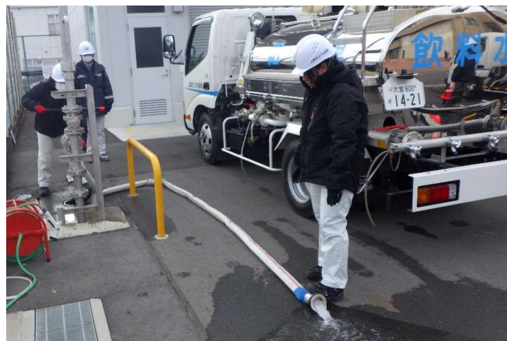
給水車への補給前にホースを洗浄
