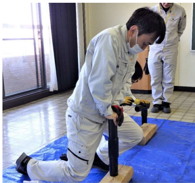
体重をかけて、HIVP管とソケットを接合
