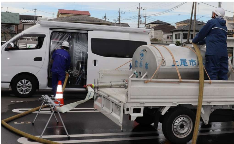
給水車からの受水槽と見立てたタンクへの圧送
