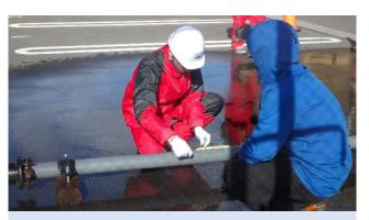
最後に木栓で止水した箇所に当て板を被せ、 番線で固定したら完成です。
