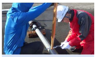
ノコギリを使用し、鋳鉄管と平行に木栓を 切断します。
