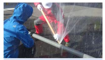
制作した木栓を、管体に滑らせながら、漏水箇所目掛けて挿入します。
