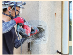
健全性調査の様子
