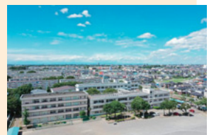
現太平中学校の全景
