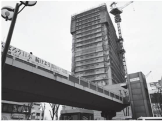
延伸が予定されている東口ペデストリアンデッキ
