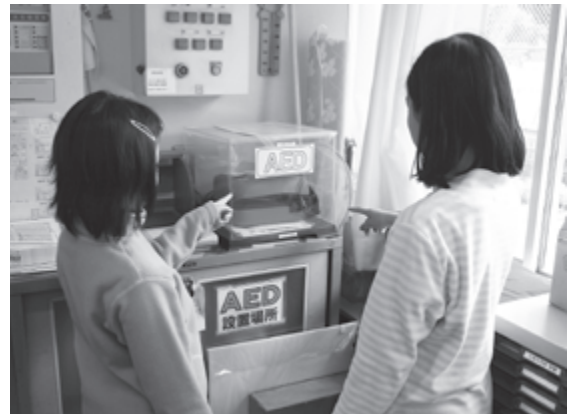
小学校内に設置されたAED
