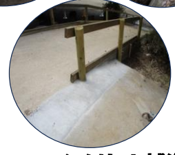
コンクリート補修
