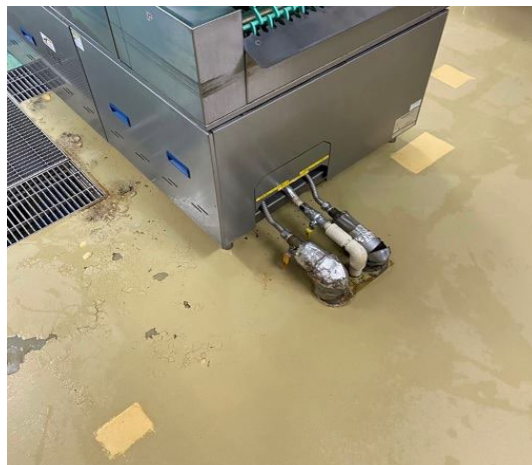
↑ 破損した床
